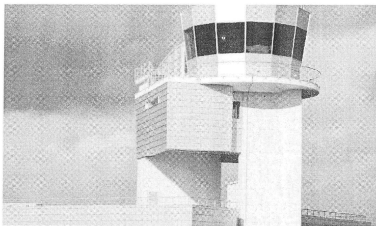
La torre di controllo dell'aeroporto di Comiso
